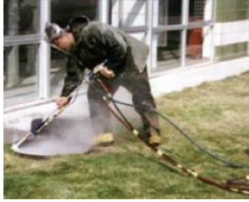
* الشكل (4) السفع بضغط الماء فائق الارتفاع
