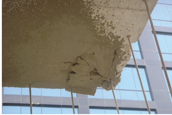
الشكل (6): انهيار الخرسانة نظراً لتركيز الإجهادات على نهاية نقاط تثبيت الأوتار
