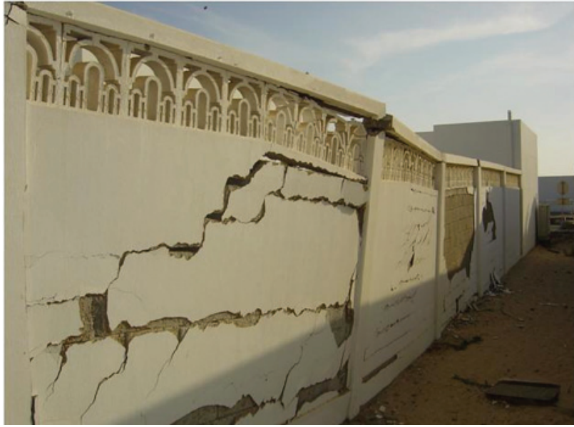
الصورة (1): تفاوت الهبوط بين الدعامات في حوائط سور بالإمارات العربية المتحدة
