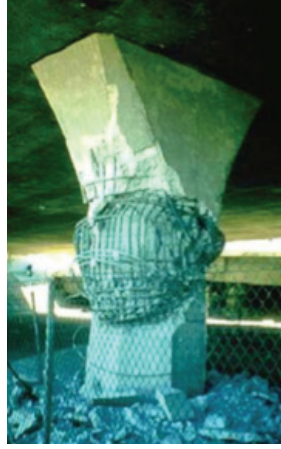
الشكل (8) : انهيار عمود (Vision 2020)
