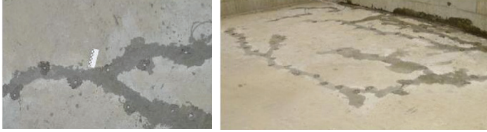
الشكل (5): الحقن بالإيبوكسي
