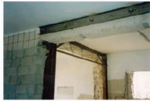
الصورة (4): تدعيم بواسطة ألواح الحديد
