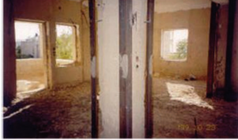
الصورة(5): تدعيم عمود بزوايا من الحديد
