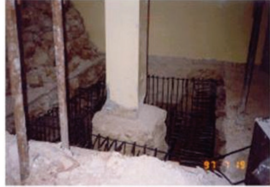
الصورة(7): تنظيف وتخشين السطح وتثبيت المسامير
