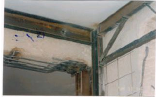
الصورة (2): تدعيم كمره وبلاطة
