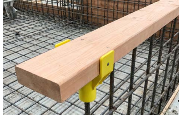
تغطية حديد التسليح بواسطة ألواح من الخشب للحماية من مخاطر اختراق الجسم (شكل رقم 4)
