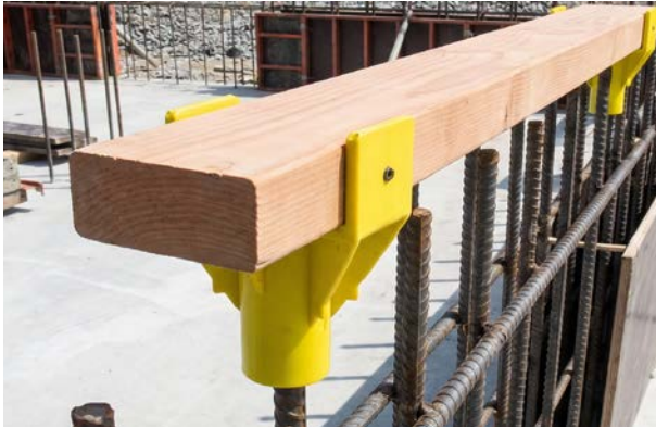
تغطية حديد التسليح بواسطة ألواح من الخشب للحماية من مخاطر اختراق الجسم (شكل رقم 4)
