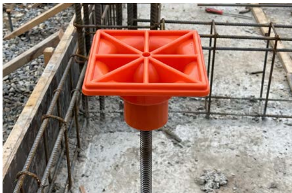
حديد التسليح وقد تم تغطية أطرافه المديبة – Capped Rebar
